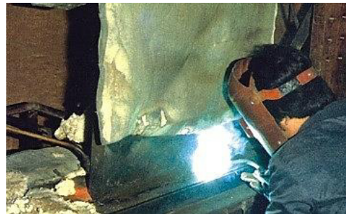
Al 바 + Cu 바 용접 Al bar + Cu bar welding
