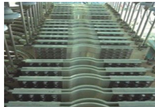
Flexible bus bar 설치
