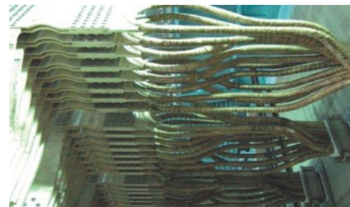
동관모선 (ID 48Ø, OD 72Ø)과 C형 동판 용접 후 Flexible 과 설치 Flexible installation works after the welding works between copper pipes and C-type copper plates
