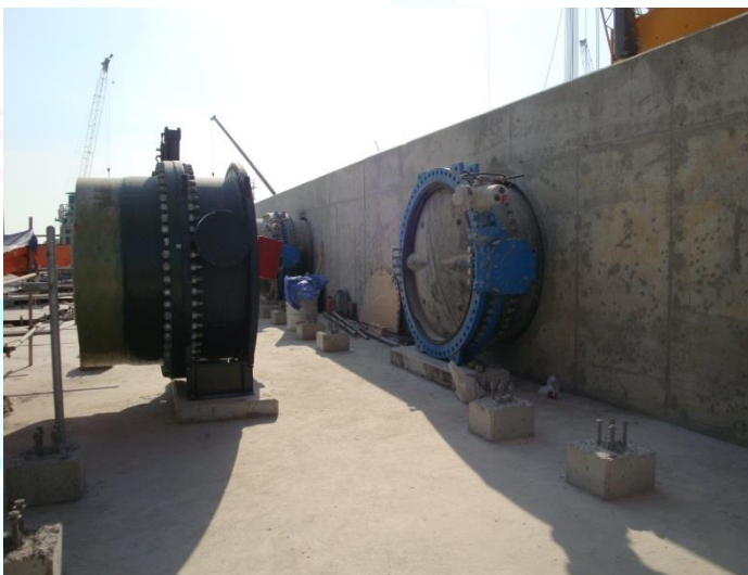
► RAS LAFFAN C IWPP PROJECT - Hyundai E&C - DN 1600
