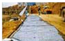
2. 다짐틀 및 지오그리드 설치
