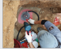
센서 설치 작업
