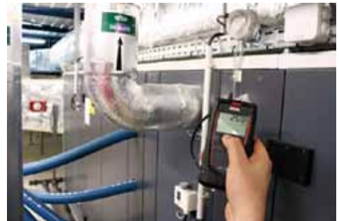
▲ 배관 또는 공간의 정압 및 차압 측정
