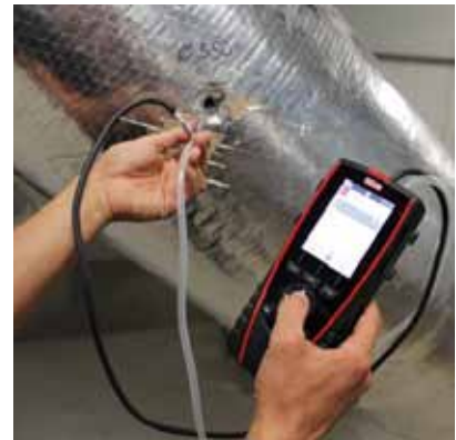
압력 모듈을 이용하여 배관 내 압력, 풍압 측정
