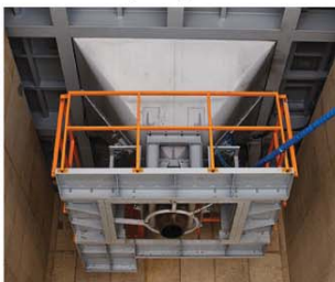
콘크리트 호퍼 & 핀치밸브 Concrete Hopper & Pinch Valve
