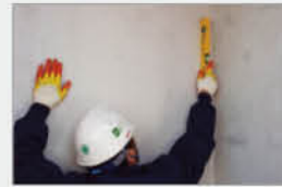
⑤ CRC보드 붙이기 수평을 맞추어 부착 후 탈락방지를 위해 고정못으로 고정하여 24시간 정도 충분히 양생합니다.
