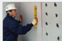
③ 복합단열판 붙이기 본드를 바른 후 30분 이내에 복합단열판을 손으로 가볍게 눌러 수평을 맞추어 부착합니다.
