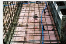
③ 철근 배근 및 콘크리트 타설 철근을 배근한 후 콘크리트를 타설합니다.
