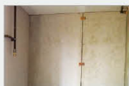
④ 양생하기 벽체와의 탈락방지를 위해 고정못으로 고정 후 24시간 정도 충분히 양생합니다.
