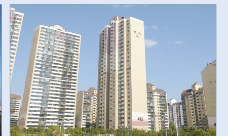
건축물의 단열 (아파트, 주택)
