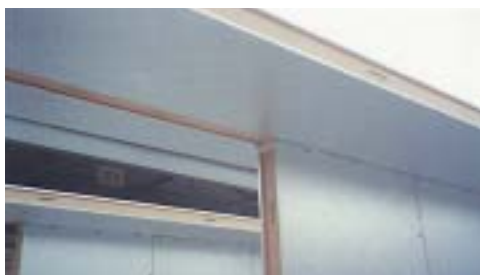
■ 판넬 조립 시공 모습
