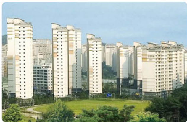
용인신봉 동일하이빌아파트 현장
