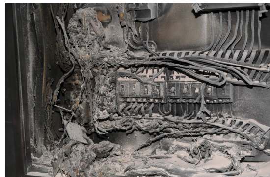
▲ 배전반 화재 사진 _ TS-70은 이러한 화재를 초기에 감지하여 피해를 최소화 하는 제품이다.
