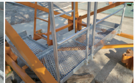
플랫폼 및 핸드레일류 용융아연도금 적용에 의한 내구성, 내식성 증대
