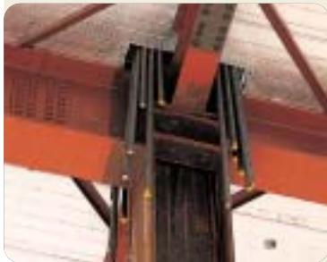
④ 기둥주위 보강 ANGLE 설치
