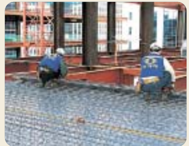
⑥ 슈퍼데크 설치
