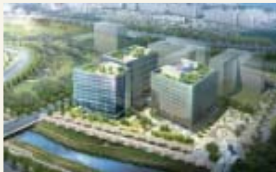
● 판교 N-SQUARE / (주)포스코건설
