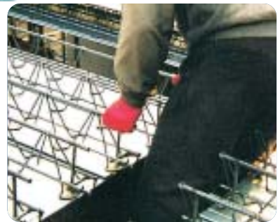
③ 슈퍼데크 설치
