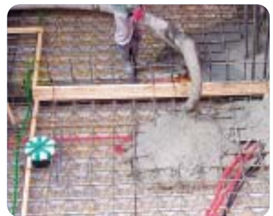
⑥ 콘크리트 타설
