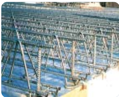
④ 슈퍼데크 설치 완료
