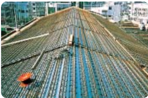
● 경사지붕 설치 (부천 송내 대우APT)
