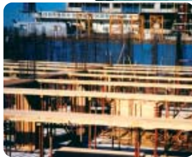
② 보거푸집 설치
