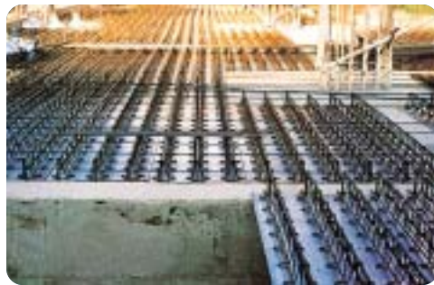
● PIT 부위 설치 (용산 중앙박물관 신축)
