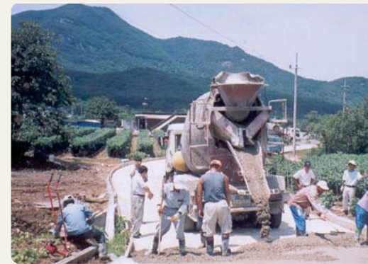
❖ 농로 포장 공사
