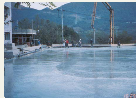
❖ 주차장 슬래브 공사
