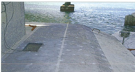
티타늄 메쉬 양극 설치 모습 View of Installing Titanium Mesh Anode
