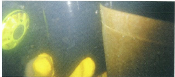
해양용 방식테이프 및 PVC 시트 설치/
